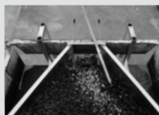
⑥ 一輪車を置き集積パネルを抜き材料を掻き出す
